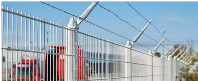
Clôture en panneaux rigides équipée de bavolets et de ronces
